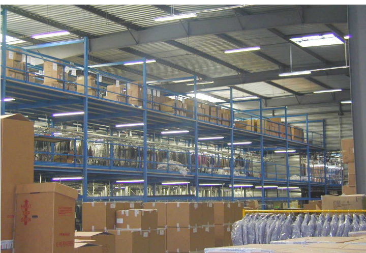
Etagebouw 2 niveaus hangende textielstockage + platform op niveau 3.
